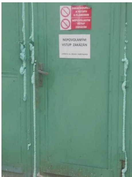
Obr. č. 12 - Utěsnění vrat
