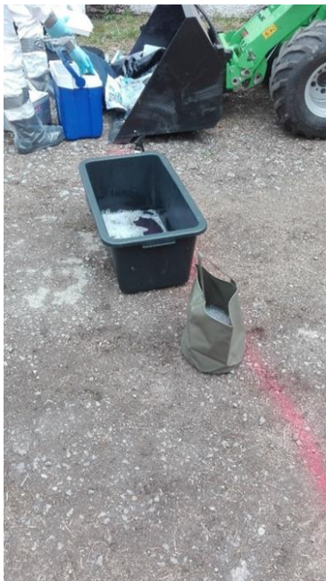
Obr. č. 3 - Příprava ke vstupu
